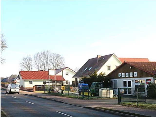
Bebauung an der Veltener Straße westlich und nordwestlich des Plangebietes
