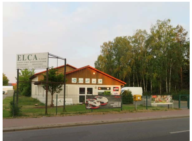
nicht störendes Gewerbe (Fachgeschäft für Rasenmäher, Poststelle) an der Veltener Straße westlich des südlichen Teils des Plangebietes
