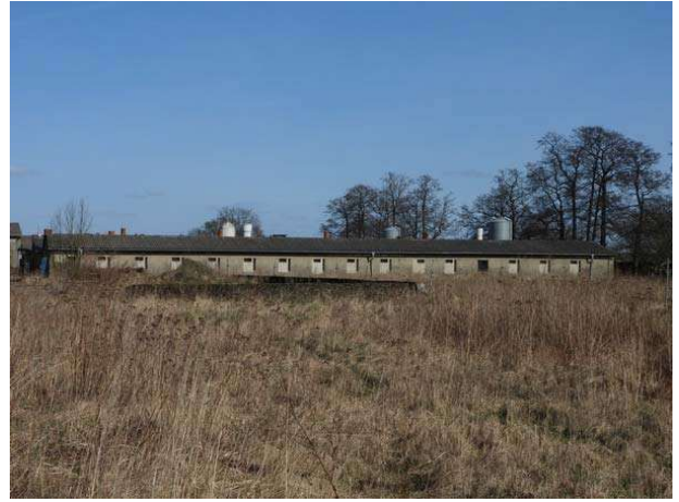
Blick nach Ost zu den Landwirtschaftsbauten, südlicher Teil
