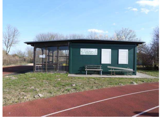
Container-Gerätehaus Leichtathletik neben der Weitsprunganlage, Blick nach Südost
