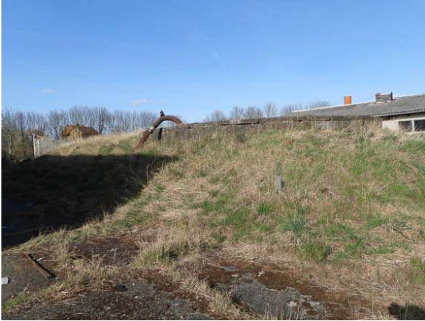
Güllebehälter östlich des nördlichen Stallgebäudes
