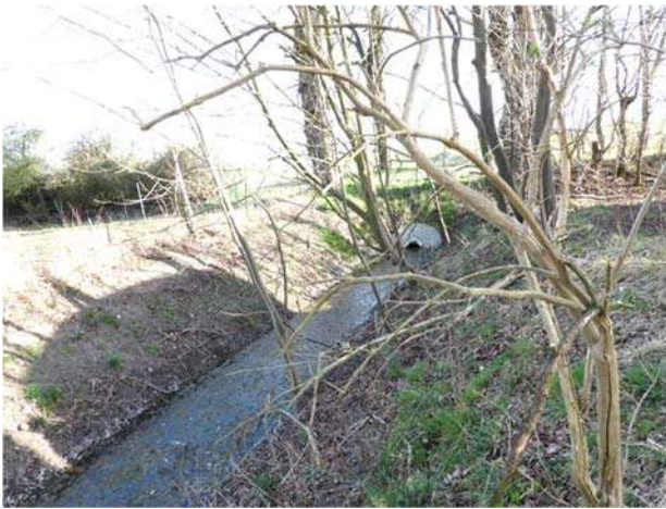
Tränkegraben mit Verrohrung unter dem Schäferweg, Blick nach Süd
