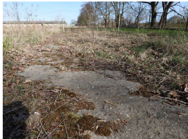
Zufahrtweg vom Tor Richtung Ost
