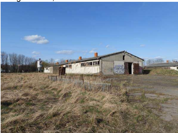
Nördliches Stallgebäude, Blick von Südwest
