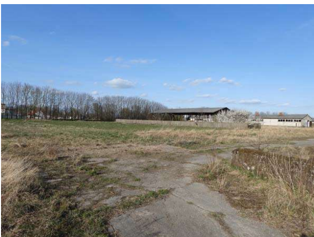
Zuwegung westlich der südlichen Stallgebäude
