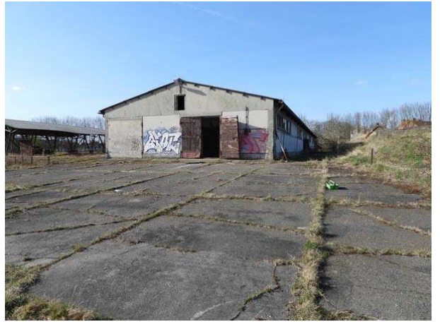
Betonfläche südlich des nördlichen Stallgebäudes
