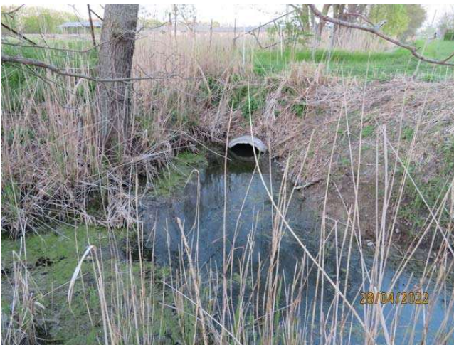
Elsgraben südlich der ehemaligen Sauenanlage, Blick von der Grabenmündung Tränkegraben Richtung Ost. Der Elsgraben weist hier eine zusätzliche Verrohrung auf
