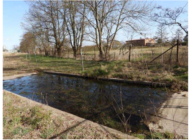
Seuchenwanne an der Zufahrt, Blick von Nordwest
