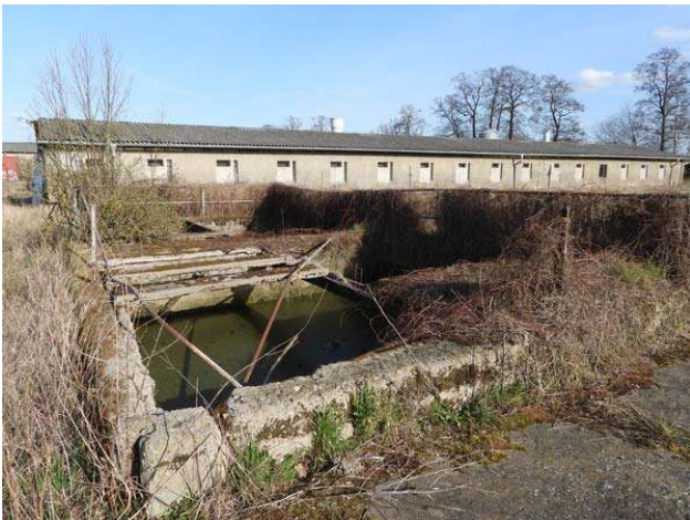
Güllebecken nordwestlich der südlichen Stallgebäude
