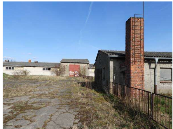
Hoffläche zwischen nördlichem und südlichen Stallgebäuden, Blick von West
