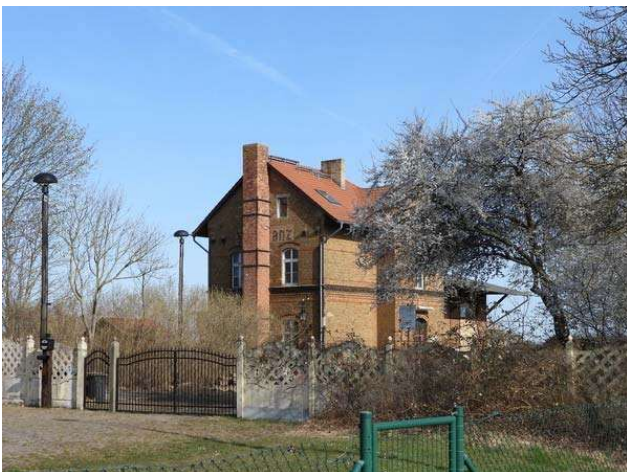
Blick nach Südost auf das ehemalige Bahnwärterhaus
