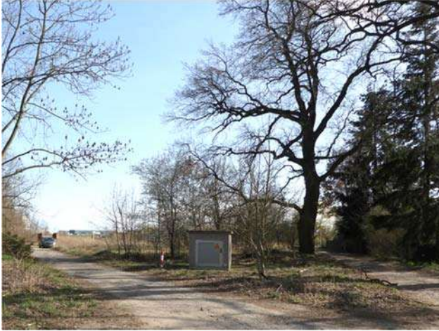
Trafo im Norden der Fläche, Blick nach Süd, ein breiter geschotterter Weg führt quer über die Fläche bis zum Schäferweg
