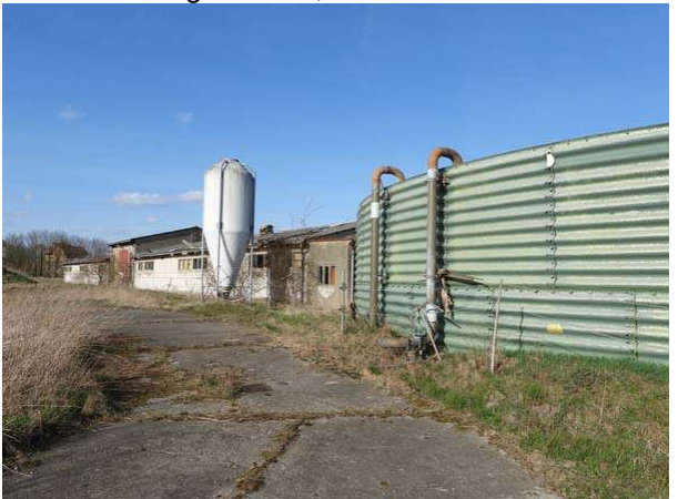
Güllebehälter, Silo, östliches Stallgebäude, Blick von Süd
