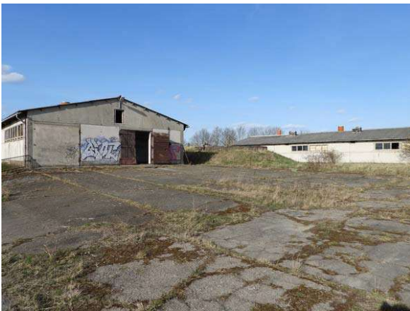
Hoffläche zwischen nördlichem und südlichen Stallgebäuden, Blick von Südwest
