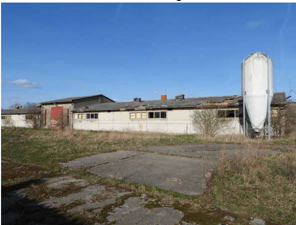
Südlicher Teil des östlichen Stallgebäudes, Blick von West
