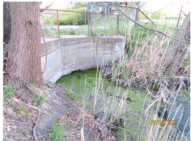
Grabendurchlass unter der Zufahrt zur ehemaligen Sauenanlage, Blick von Süd
