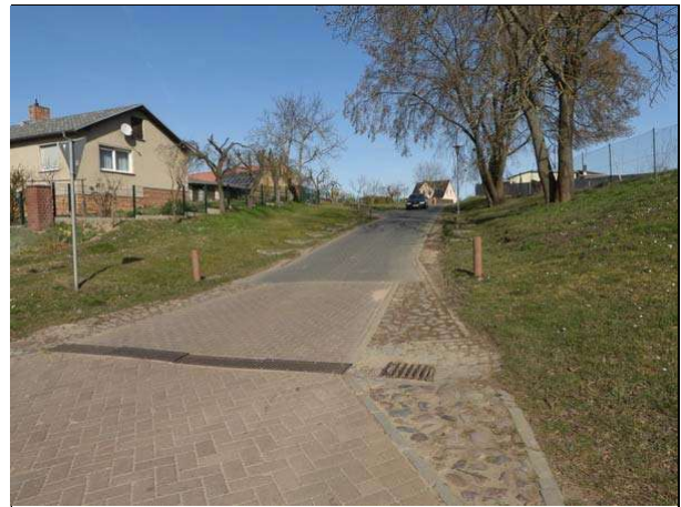
Einmündung des Schäferweges in die Lindenallee (L17), Blick nach Ost
