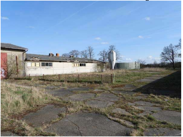
Betonflächen, Silo, Güllebehälter südwestlich des östlichen Stallgebäudes, Blick von Nord
