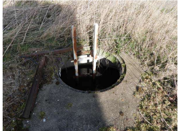
Unterirdische Grube im Hofbereich zwischen östlichem und südlichen Stallgebäuden
