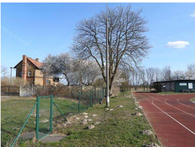
Blick nach Südost entlang der Grenze zwischen Leichtathletikanlage und Vorplatz des Regionalbahnhaltepunktes und südlich anschließendem Bahnwärterhaus-Grundstück
