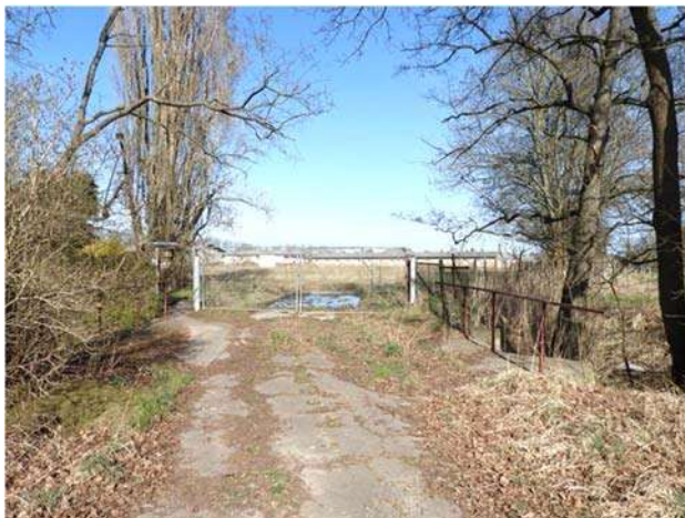
Grabenquerung im Verlauf der Zufahrt zur ehemaligen Sauenanlage, Blick von West
