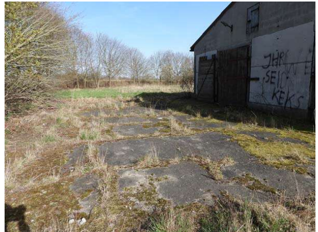
Betonfläche nördlich des nördlichen Stallgebäudes
