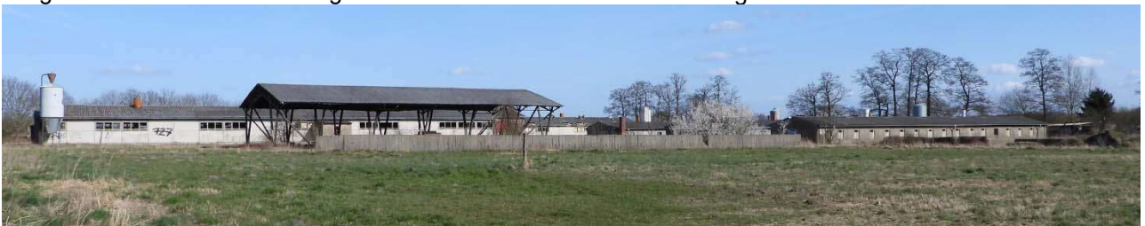
Gesamtansicht von West, Bergehalle und Stallgebäude
