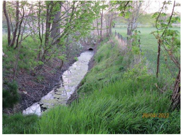
Tränkegraben, Blick vom Schäferweg nach Nord Zwischen Schäferweg und Zufahrt ehemalige Sauenanlage weist der Tränkegraben eine zusätzliche Verrohrung auf
