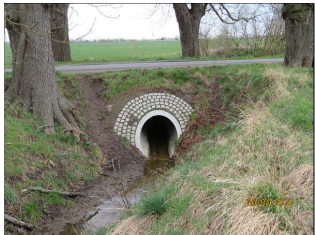
Grabendurchlass Koppehofer Feldgraben
