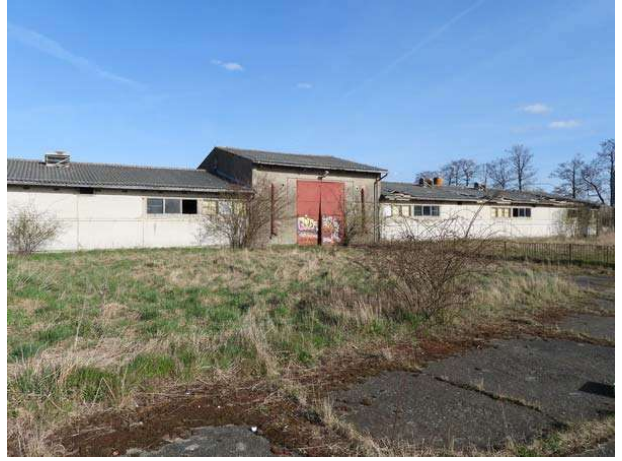
Blick von West auf das östliche Stallgebäude
