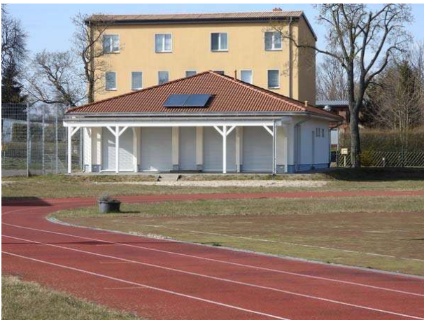
Vereinsgebäude im Norden der Leichtathletik-Anlage nahe der Bärenklauer Straße, Blick nach Nord
