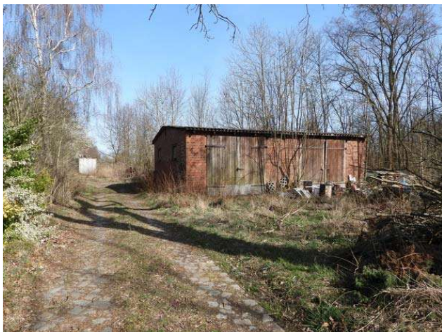
alten Wirtschaftsgebäude (nördlicher Teil der früheren Hofbebauung Koppelhof), Ansicht von West
