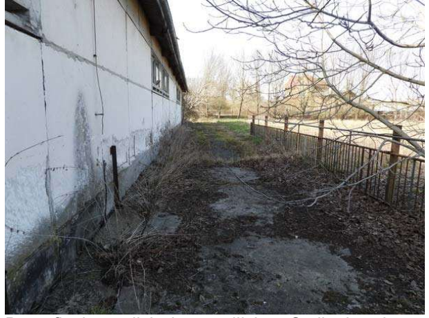
Betonfläche östlich des nördlichen Stallgebäudes
