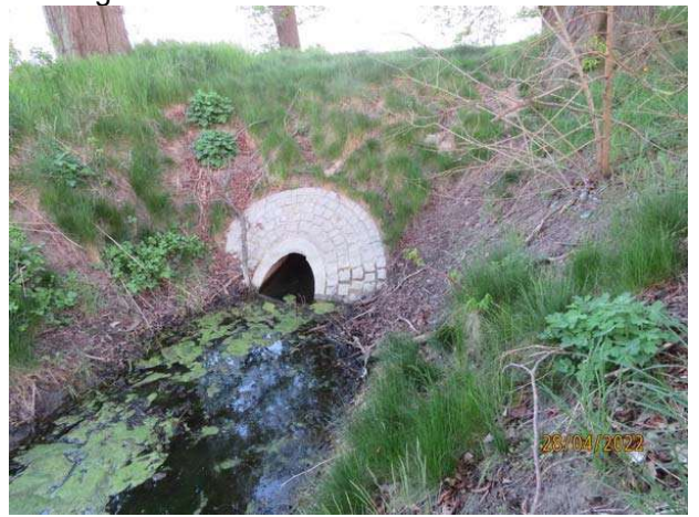
Tränkegraben, Rohrdurchlass unter dem Schäferweg, Blick nach Süd
