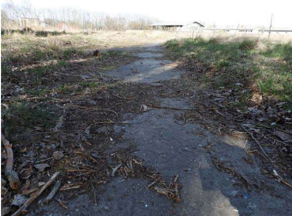
Zufahrtweg vom Tor Richtung Nordost
