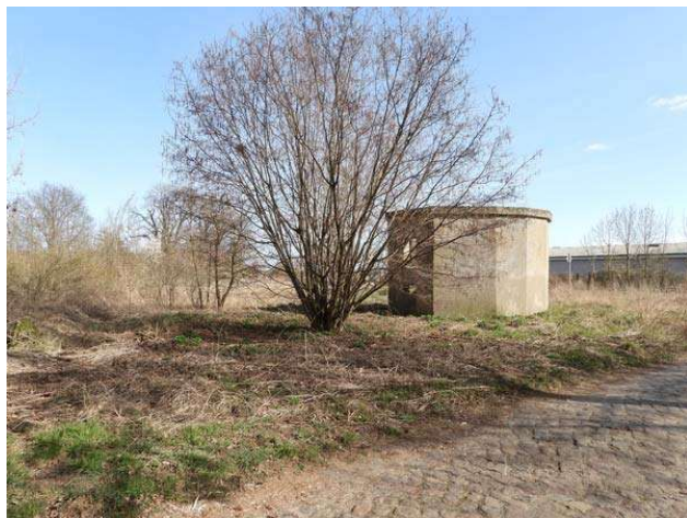
Silo im Südwesten der Fläche, Ansicht von der Straße Koppelhof
