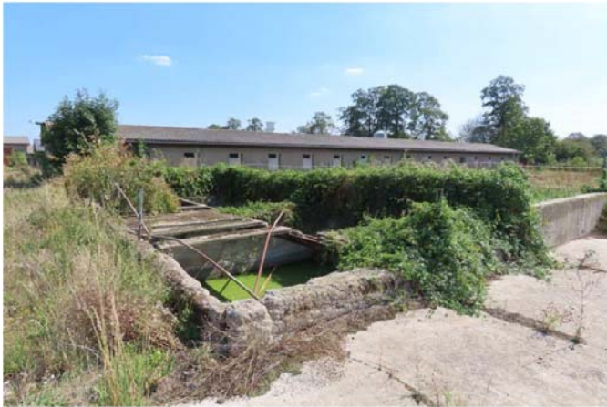
Abb. 28: Wasserbecken auf dem Grundstück
