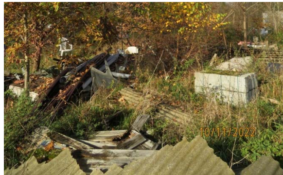
- Schutt, Müll, Baustoffe, Bauabfälle, darunter teils Großpflaster - flächenüberdeckend – versiegelnd gewertet
