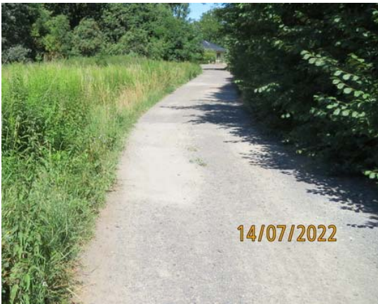
Unbefestigter teils geschotterter Weg im Bereich Koppehof
