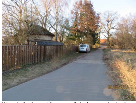
Wegebefestigung Übergang Schäferweg (Asphalt) – Koppehof (Großpflaster)
