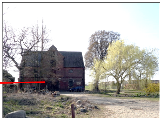
Blick von der Straße Koppehof nach West auf das denkmalgeschützte Speichergebäude Koppehof 11
