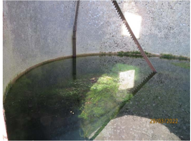
Wassergefülltes Betonsilo Koppehof SO
