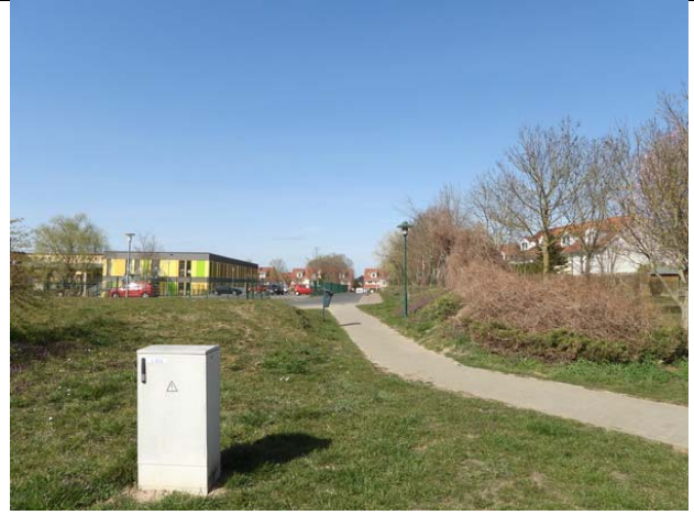
Blick entlang des Fußweges zum Erweiterungsgebäude der Grundschule
