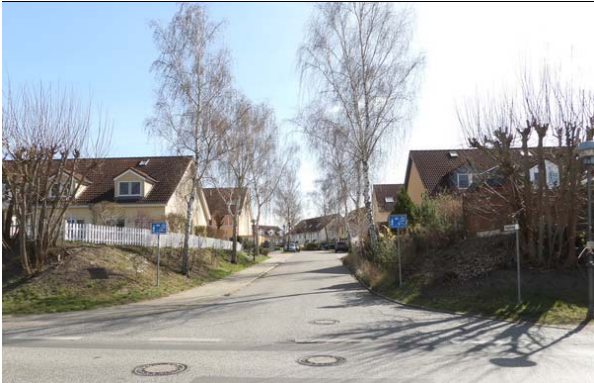
Einmündung der Hauptzufahrtstraße in die Bärenklauer Straße
